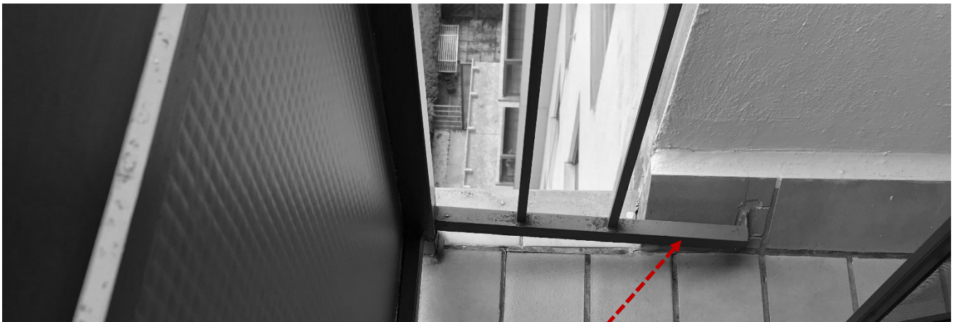
Abb. 13: Die Geländerkonstruktionen sind seitlich in den Wänden bzw. in den Fertigteilrahmen befestigt.
