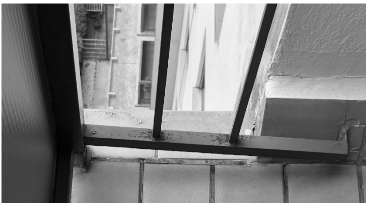
Abb. 10: Geländerbefestigung und offene Verfugung.
